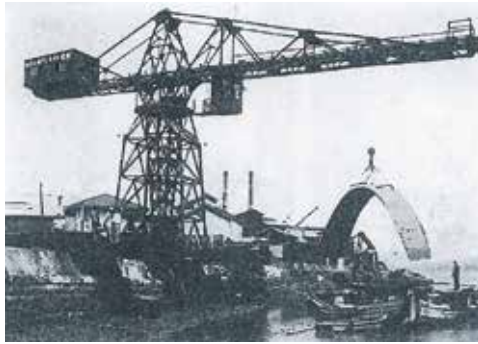
月島工場の荷揚げ作業
