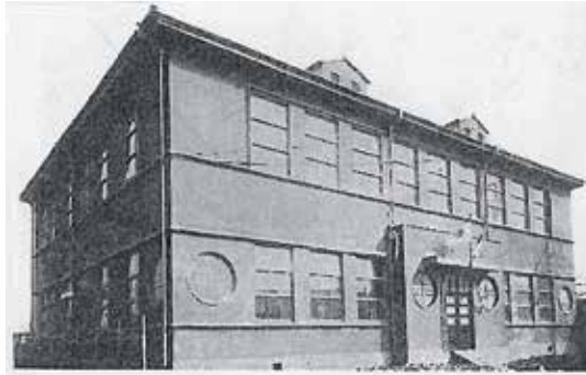
東京シャーリングの本社事務所
